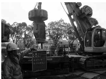
写真－3 岩盤破碎用水中ブレーカ
