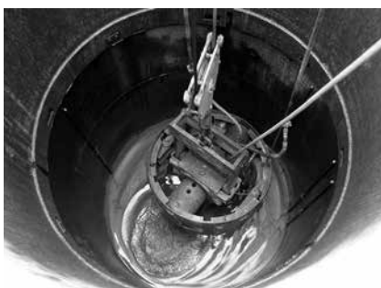
写真－4 水中ブレーカによる破碎状況
