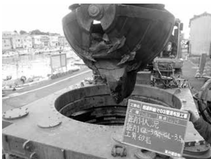
写真－2 掘削状況
