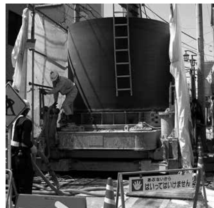
写真-2 LMV-3000RS施工状況
