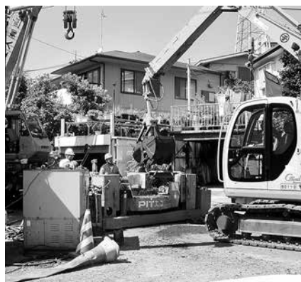
写真-2 立坑内掘削状況
