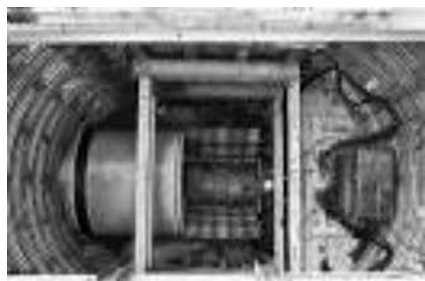
写真-1 小判型ライナープレート立坑
