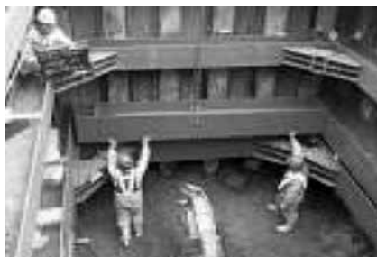
写真-2 鋼矢板打込みによる立坑
