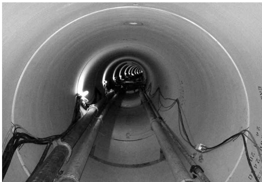
写真-1 曲線推進施工例
