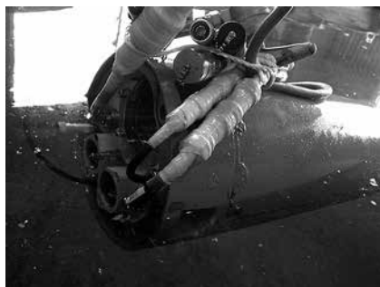
写真-1 掘進機の気密試験の状況
