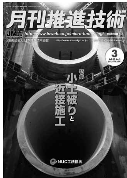
写真-2 2013年3月号表紙 呼び径3000 上下離隔1,100mm 最小土被り3.5m
