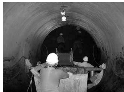
写真-1 刃口式推進工法 人力による掘削状況 呼び径3000
