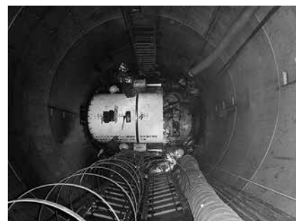
写真-4 掘進機発進状況
