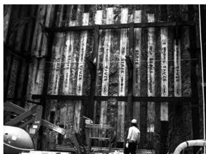
写真-5 立坑掘削完了時の状況
