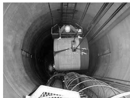
写真-1 推進管吊り降ろし
