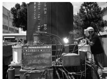
写真-8 ケーシング溶接状況
