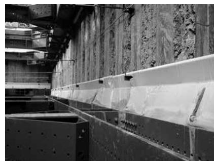
写真-2 モルタル注入で土圧を均等に腹起しに伝達
