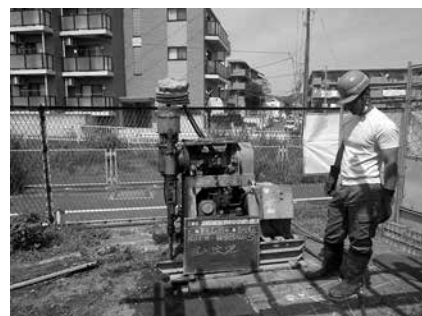
写真-5 地盤改良状況
