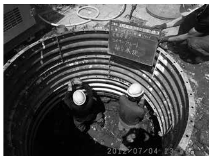
写真-3 ライナープレート工法施工状況
