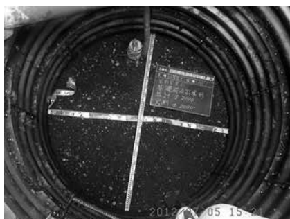
写真-4 ライナープレート工法仕上り状況
