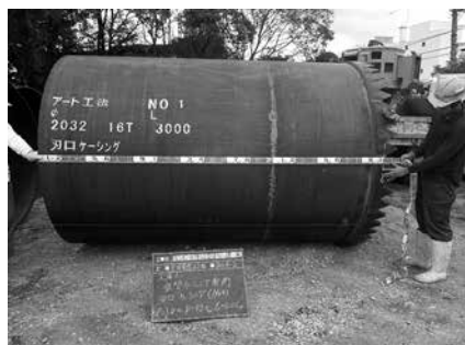
写真-6 刃口ケーシング
