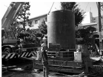
写真-7 ケーシング建込み状況
