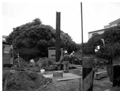
写真-1 鋼矢板工法施工状況
