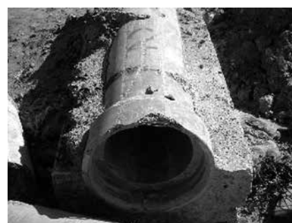
写真-3 巻きコンクリート
