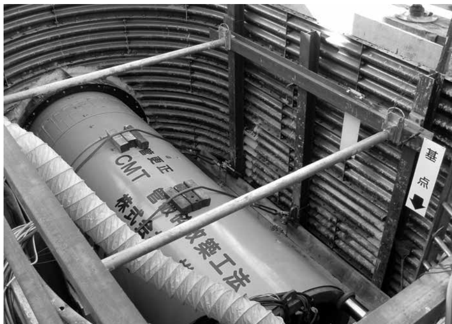
写真-1 CMT改築工法現場実証実験
