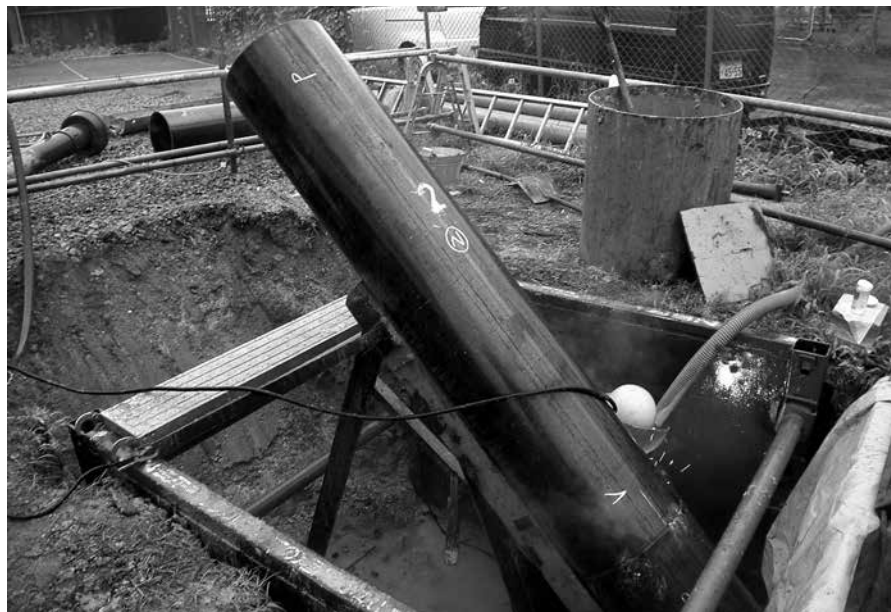
写真-2 インパクトモールIHC工法（取付管工法）
