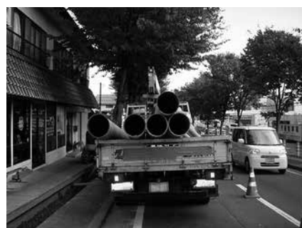
写真-4 φ300mm長距離配管敷設状況
