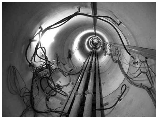
写真-2 中間滑材注入装置
