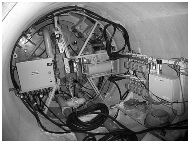
写真-1 先端注入滑材装置
