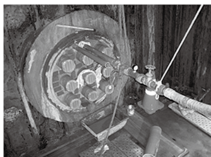
写真-2 管内中詰め状況
