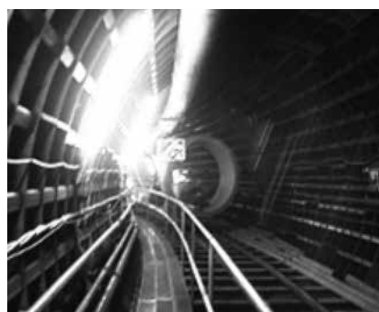
写真-1 推進管の坑内運搬状況
