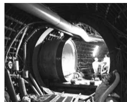
写真-2 推進管の横坑内への引き込み
