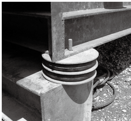
写真-1 防振装置設置状況
