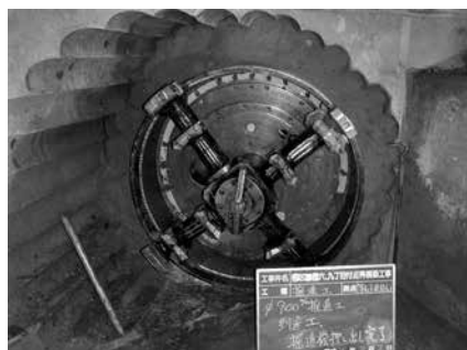
写真-2 特殊マンホールに斜め到達状況
