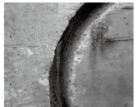
写真-5 コア切削部
