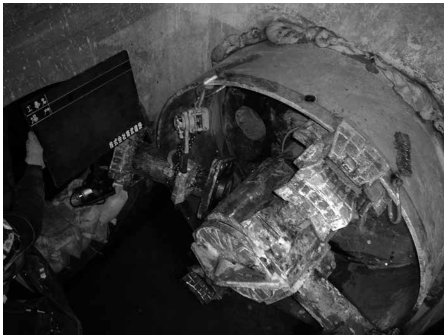
写真-1 既設マンホール到達
