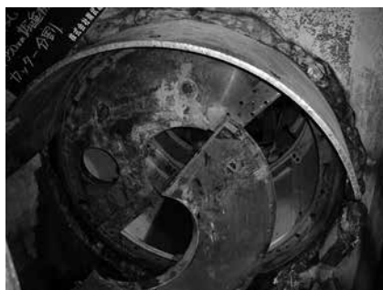
写真-2 掘進機残置・解体
