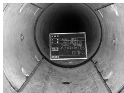
写真-3 インナーパネル設置
