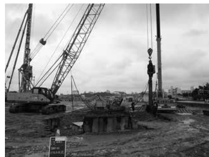
写真-3 大型仮設施工状況
