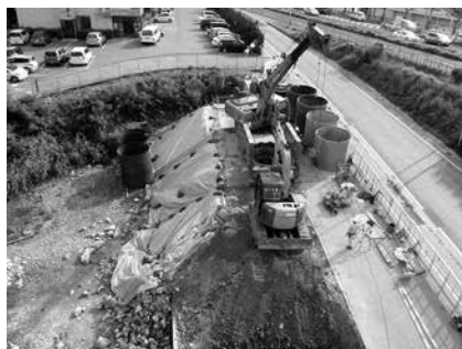
写真-2 狭隘な施工箇所
