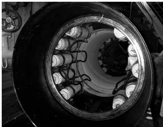
写真-3 2連中押装置（中押実効ストローク確保）
