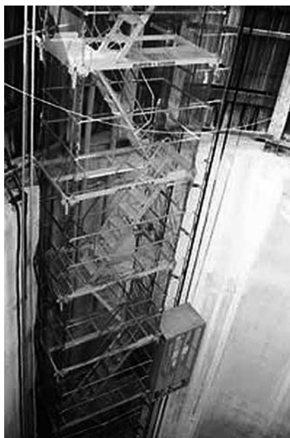
写真－1 設置状況①
