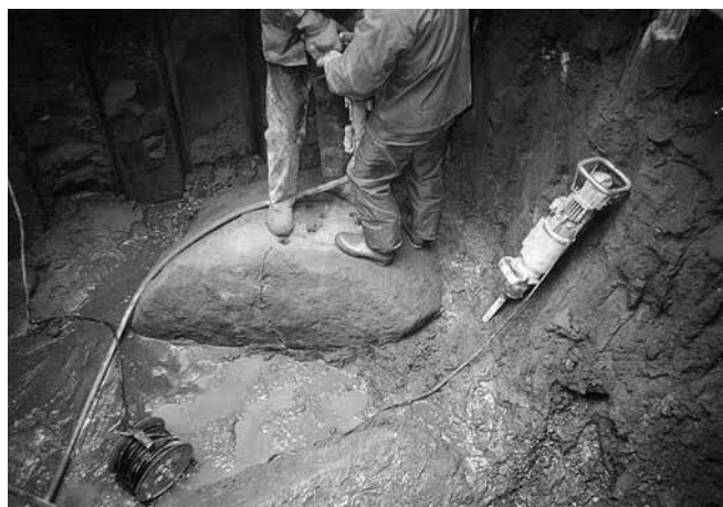
写真-3 巨石地盤の一例（1mを超える巨石）
