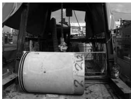
写真-6 発進基地内の状況と使用した推進管
