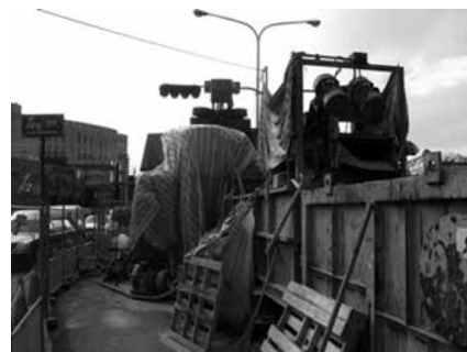
写真-5 発進基地とその周辺状況
