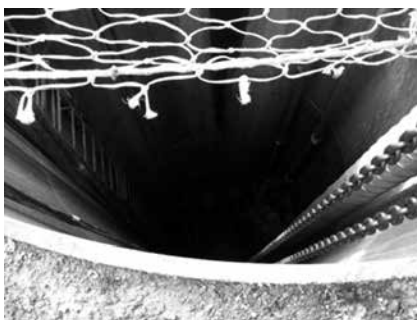
写真-7 発進側立坑内の状況 (立坑寸法：φ3,290×深さ13,000mm)
