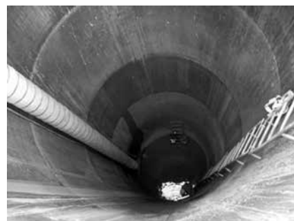
写真-8 到達側立坑内の状況 (立坑寸法：φ3,290×深さ13,000mm)
