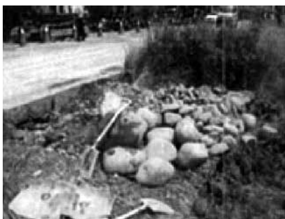
写真-4 施工路線付近の調査にて出土した土質状況 (礫径φ750mm)
