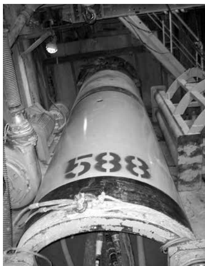
写真－1 ガラス繊維鉄筋コンクリート管（SSP） （世界記録時 588本目施工状況）
