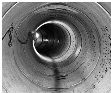
写真-2 E-MAX推進管 急曲線R=12m施工状況
