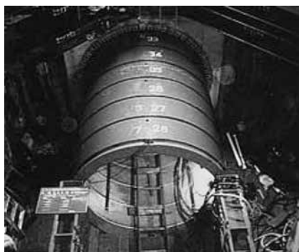
写真-3 MAX推進管 大土被り（大深度）施工状況
