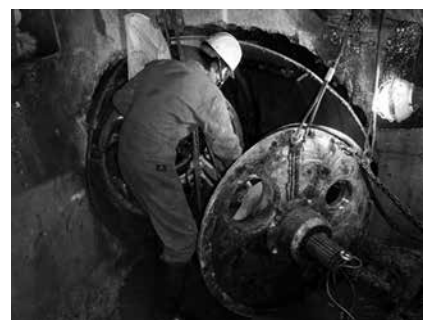
写真-3 掘進機分割回収
