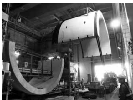
写真-1 超大口径管推進の施工
