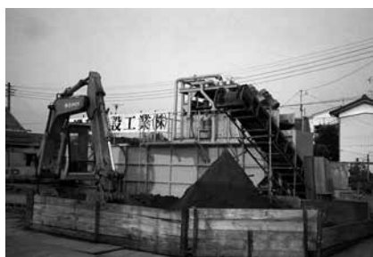
写真-1 泥水式推進工法一次処理プラントと掘削土砂
