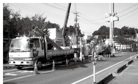
写真-1 施工状況（垂直推進）
