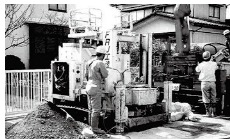
写真-2 施工状況（推進装置）
