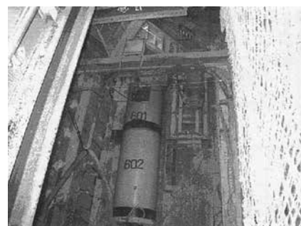
写真－2 世界最長1,447mの推進工事において602本目の推進管の設置状況
