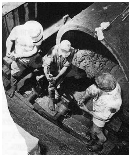
写真-1 手押シップジャッキによる推進状況
