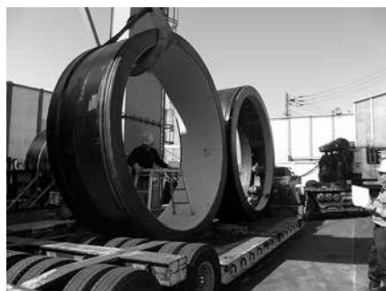
写真-1 特殊中押管 S型、T型
