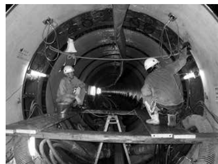
写真-4 曲線内での中押稼働状況
