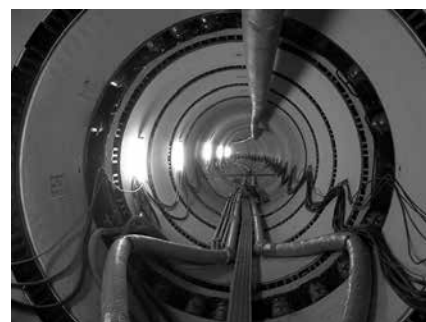
写真-3 管内状況（曲線部）
