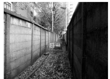
写真-1 採用された狭隘な施工場所
