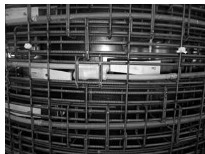
写真-3 Xアンカーの配置
