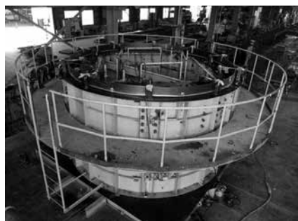
写真-1 型枠全景
