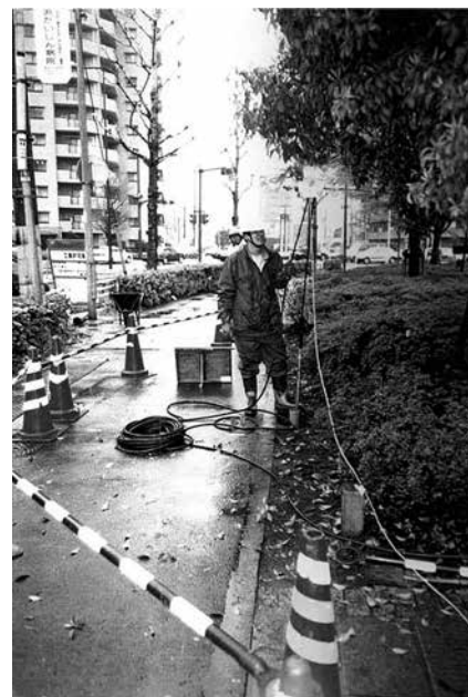
写真－2 磁気探査ボーリング
