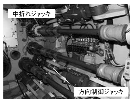
写真-4 掘進機中折れ装置
