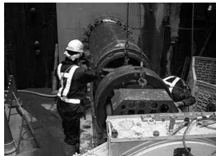
写真-4 先導体を再挿入し切削状況
