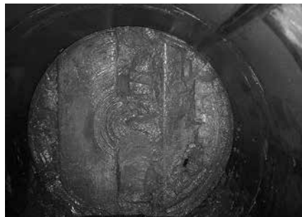
写真-3 先導体を引き戻した切羽の状況
