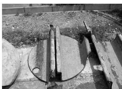
写真-2 切削除去したシートパイル
