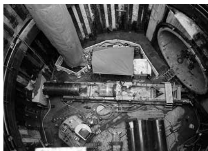
写真-1 立坑内の状況
