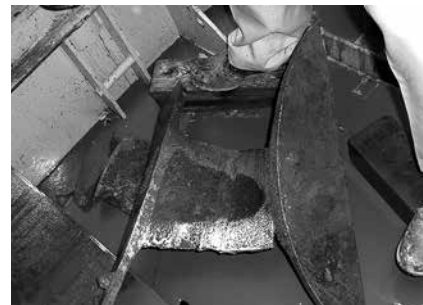
写真-5 切削除去したH鋼
