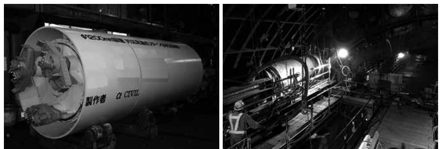
写真-6 地下高速道路拡幅トンネル内ランプ工事：大口径放射状パイプルーフ工事（左：使用掘進機（地中リターン機構）、右：施工状況）（鋼管（ \phi 1,200\text{mm} ）曲線施工）
