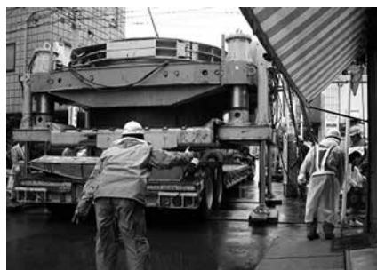
写真-3 ART-300TE 35tトレーラーから積み降ろし作業風景 型式：ART-300TE 適用径：φ2,500～3,000mm 掘削トルク：980kN・m（100tf・m） オタリ式自走システム搭載
