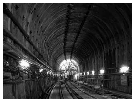
写真ー5 坑内全景
