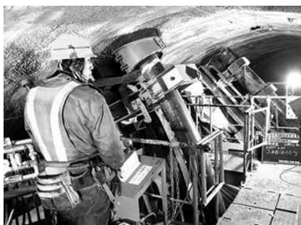
写真ー3 推進状況
