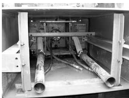
写真-9 ツインヘッドの取付け状況（背面）
