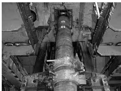
写真ー4 推進状況
