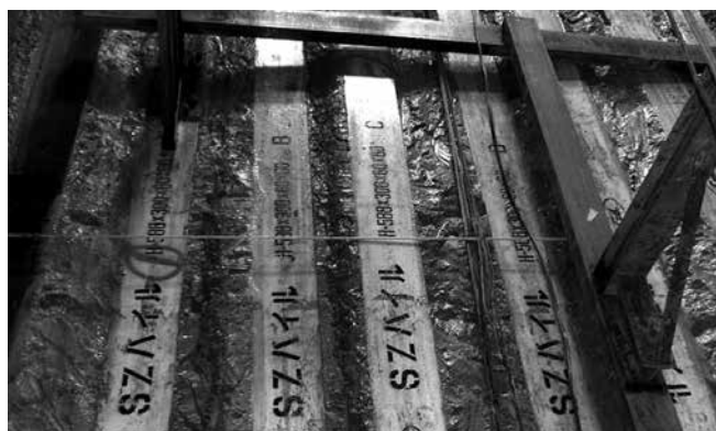
写真-2 SZパイルを用いた土留壁
