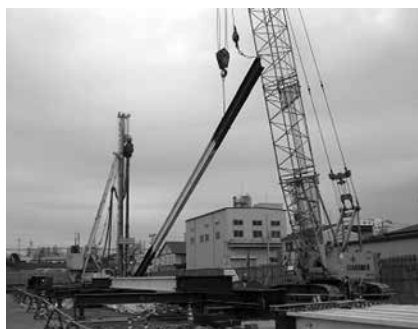
写真-4 建て起こし状況
