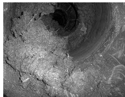
写真-5 スクリュコンベア内の排土
