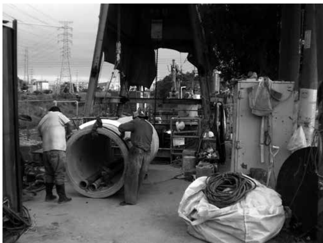
写真-1 中口径管推進工事現場
