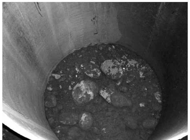
写真-2 小口径管推進現場土質状況 (700mm程度の玉石)
