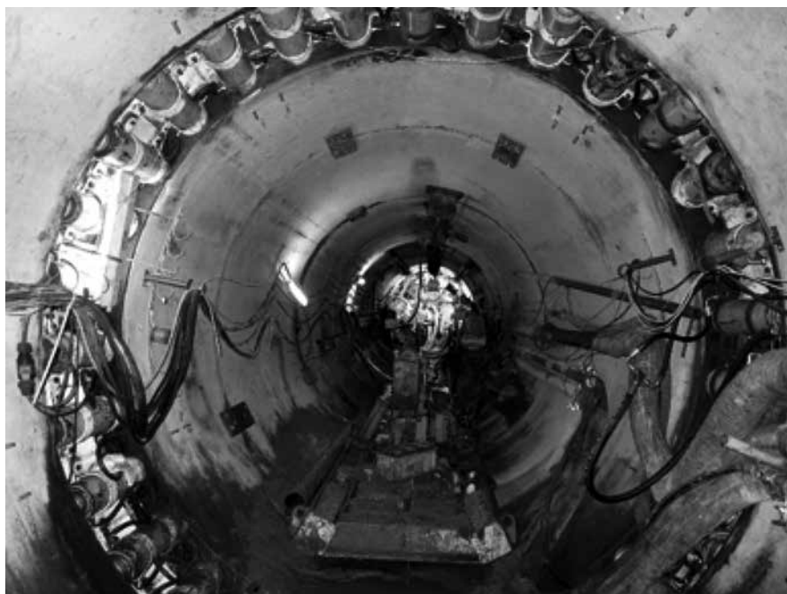
写真-2 管内状況
