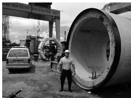
写真-1 現場サイゴン川横断推進の現場
