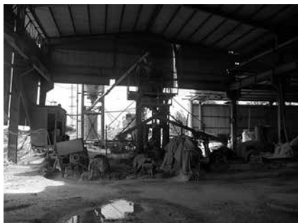
写真-1 ベトナムの遠心力成形設備（その1）
