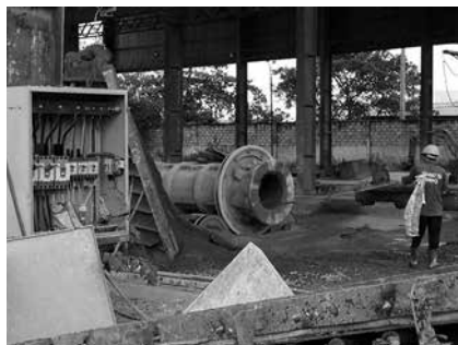
写真-2 ベトナムの遠心力成形設備（その2）
