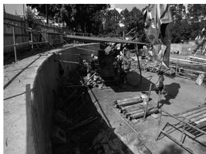
写真-1 仮設アンカー施工状況
