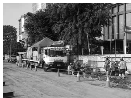
写真-5 薬液注入工の施工状況
