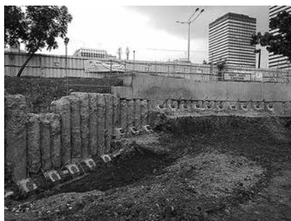
写真-2 仮設アンカー完成
