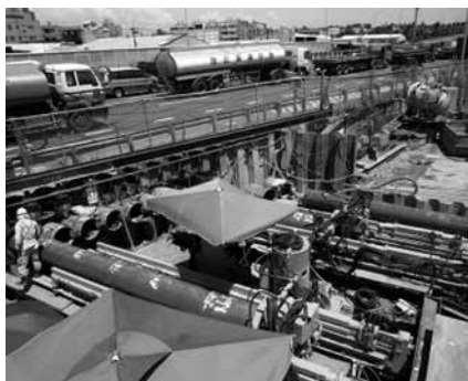
写真-2 高雄市パイプルーフ工事現場
