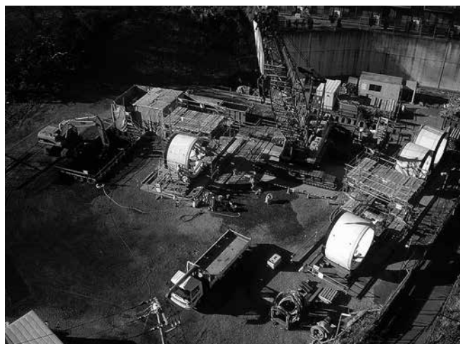
写真-2 PC型による最初の施工（JR越え）
