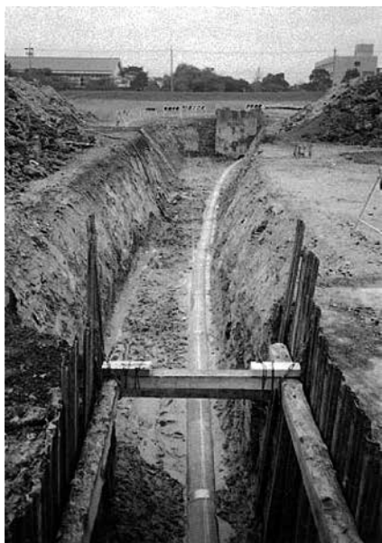
写真-1 ヒューム管掘り出し状況
