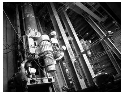
写真－1 パイプルーフ施工状況
