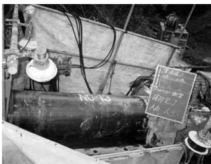
写真-2 オーガ方式施工状況
