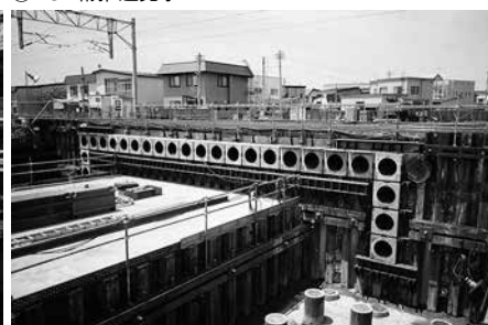
写真-3 【ステップ1】PCR桁推進工
