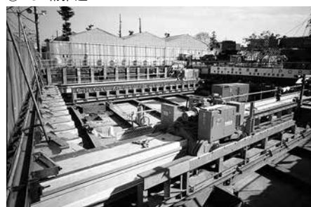
写真-3 【ステップ1】PCR桁推進工
