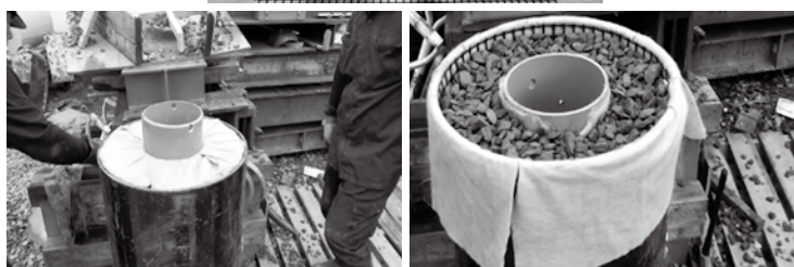
写真-1 砕石ドレーンバック
